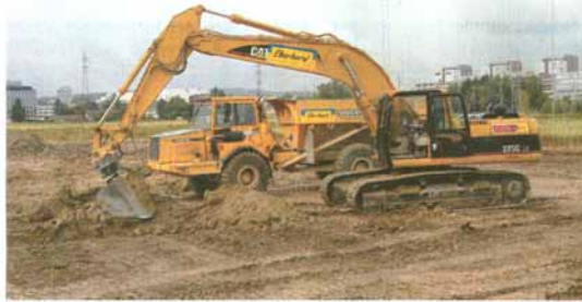
Die schweren Baumaschinen sind aufgeföhren.
