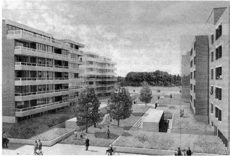
Nun ist es soweit – die ersten 34 Mietwohnungen entstehen im Glattpark.
