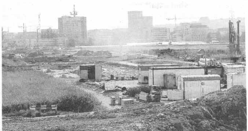
Trotz der derzeitigen Grossbaustelle – die Zahl der Wohninteressenten im Glattpark überraschen sogar die Verantwortlichen.
