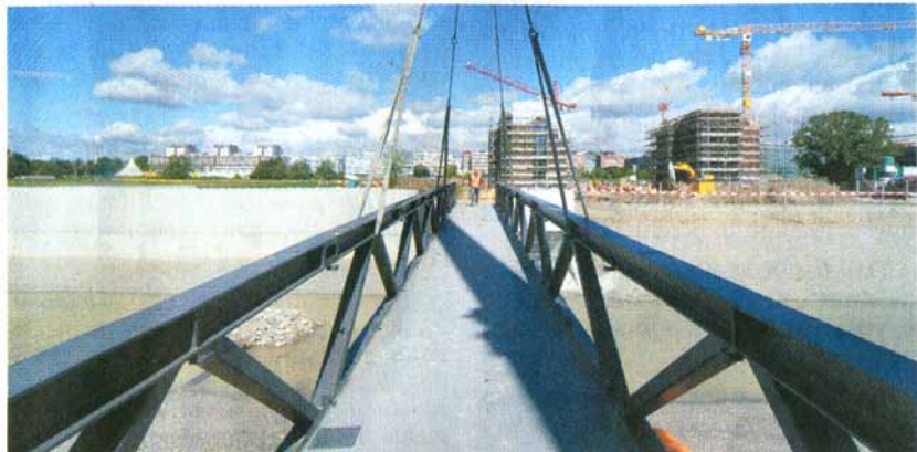
Die Fussgängerstege über den See sind montiert.
