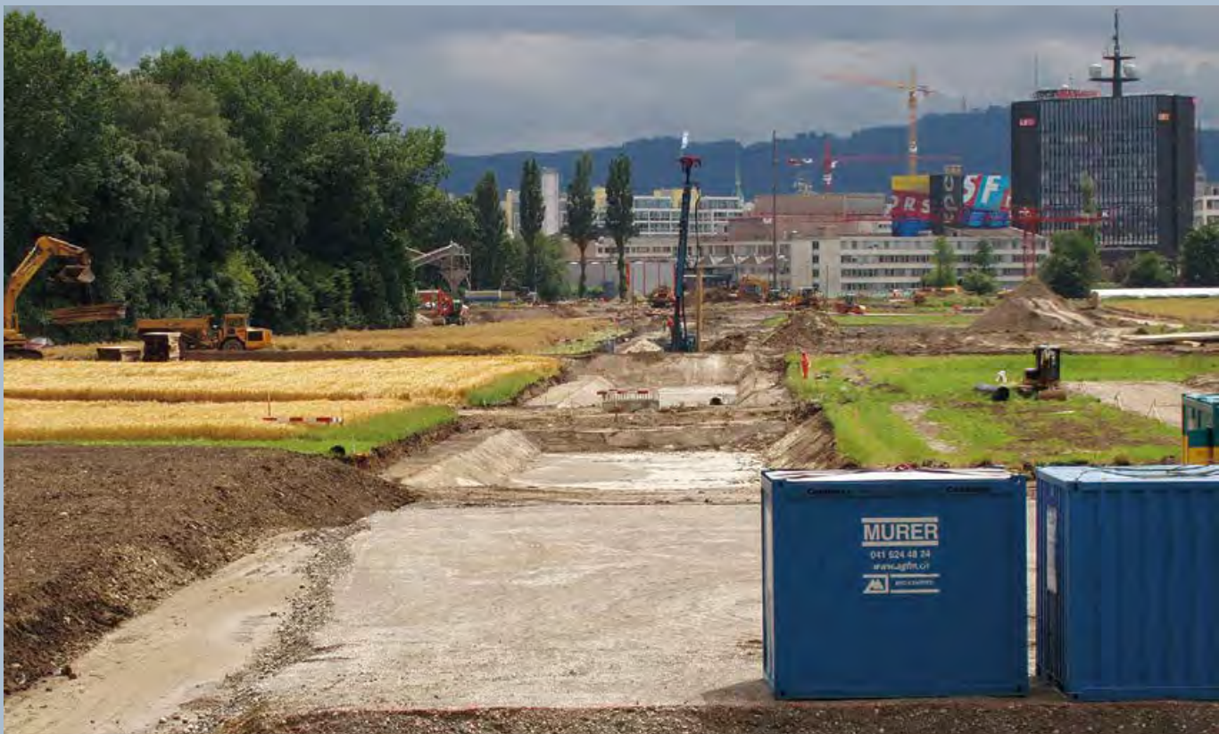
Im Sommer 2006 wird bereits am künftigen See gebaut.
